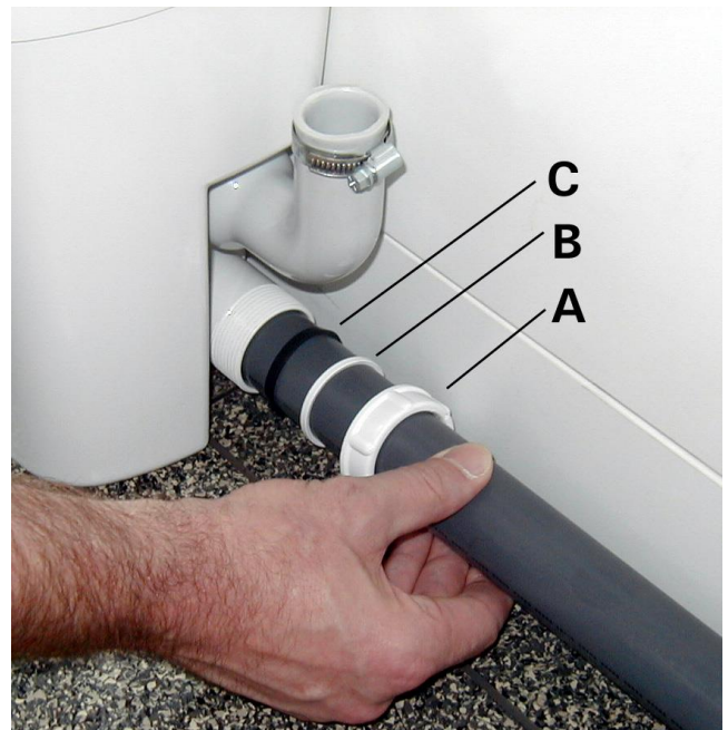
(Abb.2) Stecken Sie die Überwurfmutter (Pos. A), den Druckring (Pos. B) und den schwarzen Keil-Dichtring (Pos. C) wie abgebildet auf die DN 40-Abflussleitung und schieben Sie diese bis zum Anschlag in die Zulauföffnung des Behälters. Befestigen Sie die Abflussleitung, indem Sie die Überwurfmutter am Zulaufstutzen festdrehen, dabei muss der schwarze Keil-Dichtring zwischen Überwurfmutter und Zulaufstutzen liegen.
