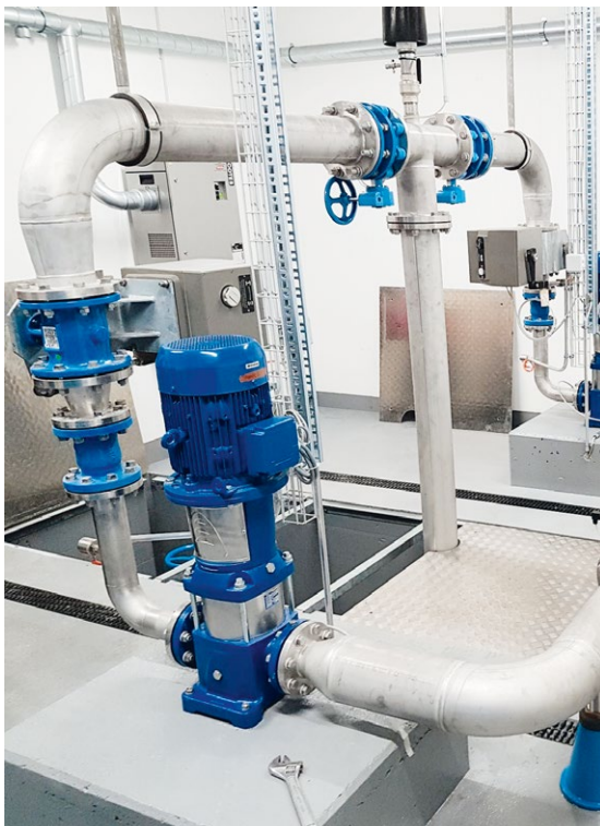
Beispiel einer Verbindungspumpe von zwei kommunalen Wassernetzen.
