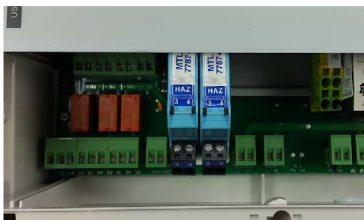
Abb. 2 Stück Zenerbarrieren in 1-Pumpen - ohne Trennplatte -
