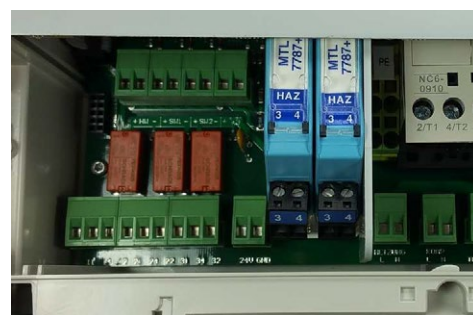
Abb. 2 Stück Zenerbarrieren in 2-Pumpen - mit Trennplatte -
